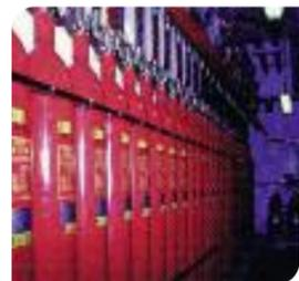
Le CO2 agit par étouffement en abaissant la concentration d'oxygène jusqu'à un niveau où la flamme ne peut plus se développer. Le CO2 peut être utilisé en protection d'objet sans que le risque soit cantonné dans un volume étanche conformément à la règle R3 de l'APSAD. Le taux de concentration utilisé pour le CO2 est mortel.
