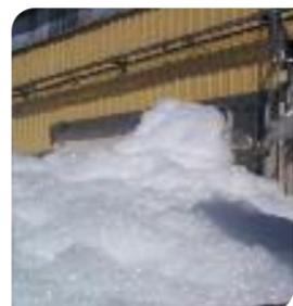
La mousse agit principalement par étouffement en isolant le combustible et l'oxygène par une couche de mousse étanche. L'effet de refroidissement est généralement secondaire. En fonction de la nature du risque et de sa hauteur, il sera appliqué une mousse bas, moyen ou haut foisonnement.
