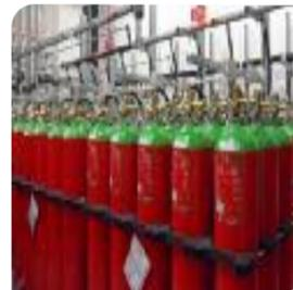
Le gaz neutre agit par étouffement en abaissant la concentration d'oxygène jusqu'à un niveau où la combustion ne peut plus être entretenue. Les principes d'application et les contraintes sont identiques à celles des gaz inhibiteurs : étanchéité du volume protégé, maintien de la concentration pendant 10mn, résistance mécanique de l'enceinte à l'effet de surpression (mise en place d'un clapet),... Le gaz neutre nécessite environ 3 fois plus de bouteilles que le gaz inhibiteur.
