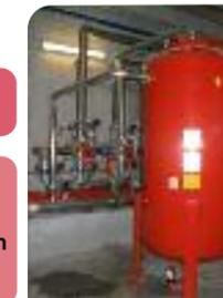
L'extinction se fait par inhibition de la réaction de combustion. Le procédé peut être appliqué en ambiance ou en ponctuel. La poudre est choisie en fonction de la classe de risque.
